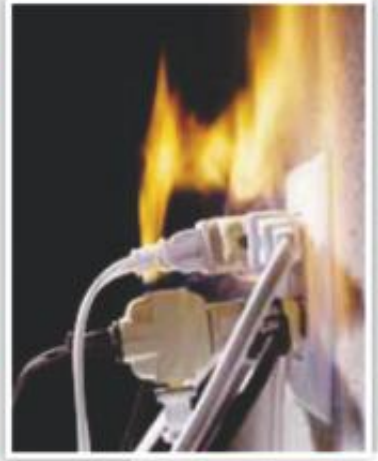
شكل (٢-١٩): زيادة التحميل الكهربائي يكون سبباً في حدوث الحرائق.
